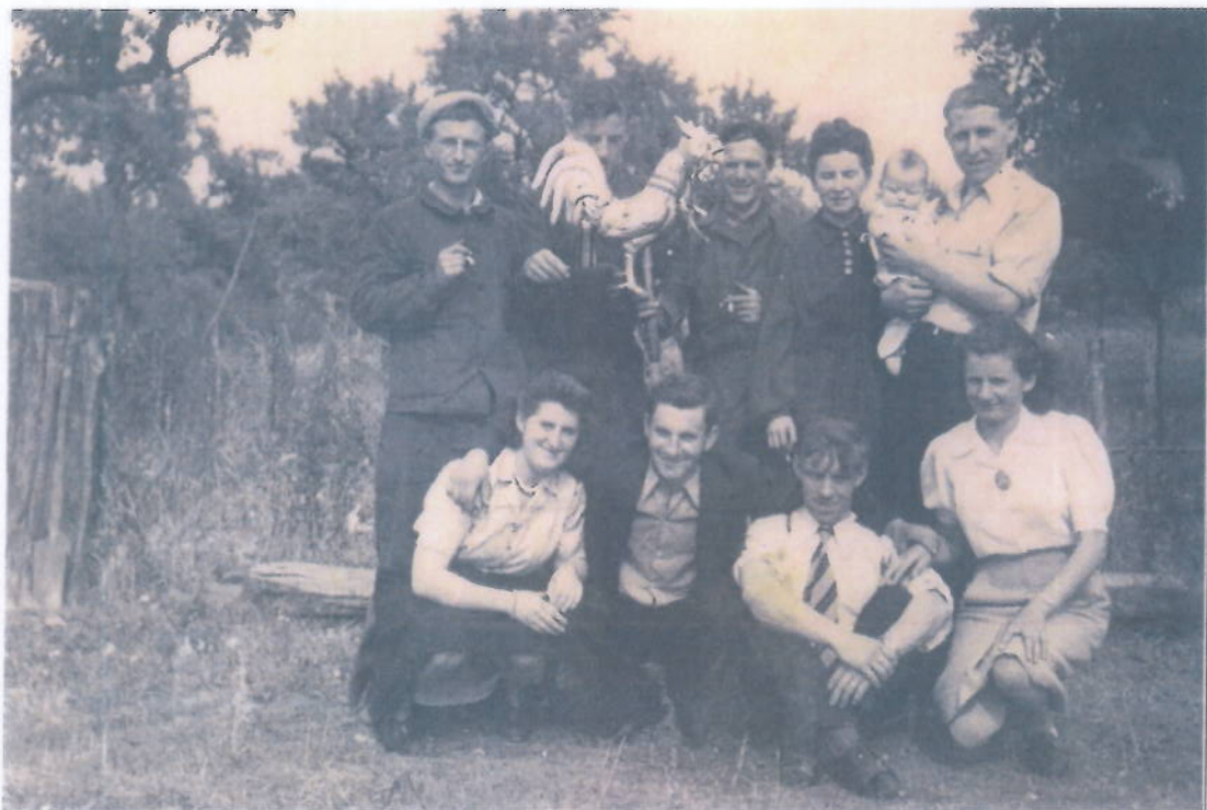
Photographie datée de septembre 1947 à l'occasion de la fin des travaux de réfection du dôme du clocher et de la restauration du coq. On note la présence des ouvriers et de quelques habitants du village : Mr DEPARIS Lucien, SCHMITT Jean, SCHMITT Juliette et Nicole bébé.
